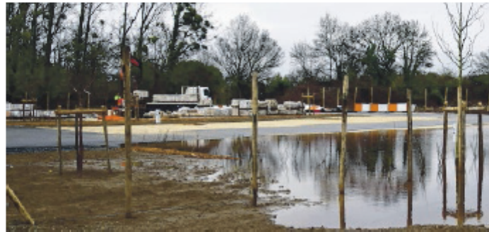
A Villandry, le nouveau parking des camping-cars a été inondé suite à une remontée des eaux la semaine dernière.
